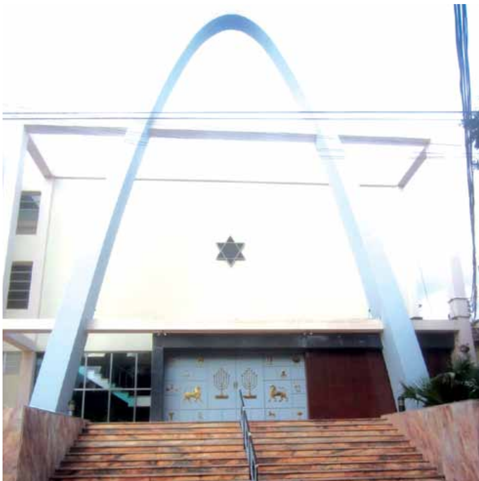
> Fachada de la sinagoga Beth-Shalom.
